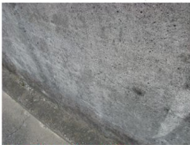
古いコンクリート基礎
