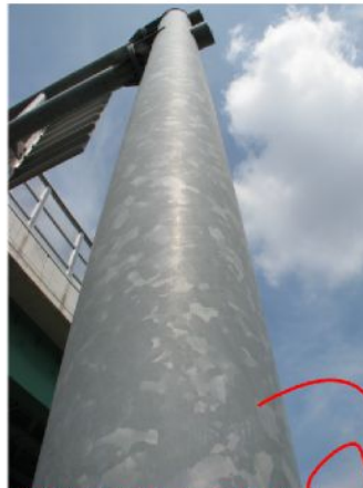
国道の案内表示支柱
